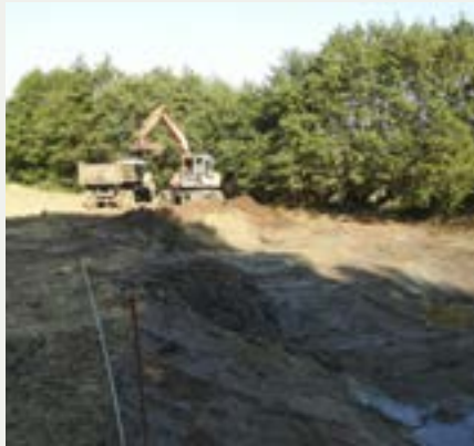
▲ Teich im Bau
