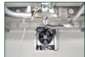
Kühlraum mit im Aggregat integrierter Frostsicherung und bündigem Wandeinbau, dadurch kein Platzverlust im Kühlraum.
