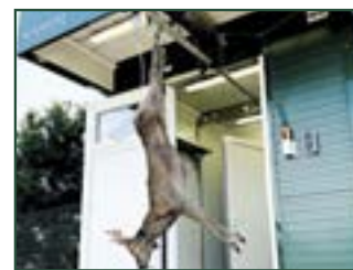
Vordach beleuchtet, mit Seilwinde und Start der Rohrbahn durchgehend bis in den Kühlraum.
