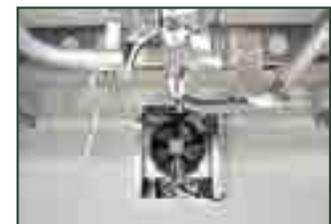
Kühlraum mit im Aggregat integrierter Frostsicherung und bündigem Wandneubau, dadurch kein Platzverlust im Kühlraum.
