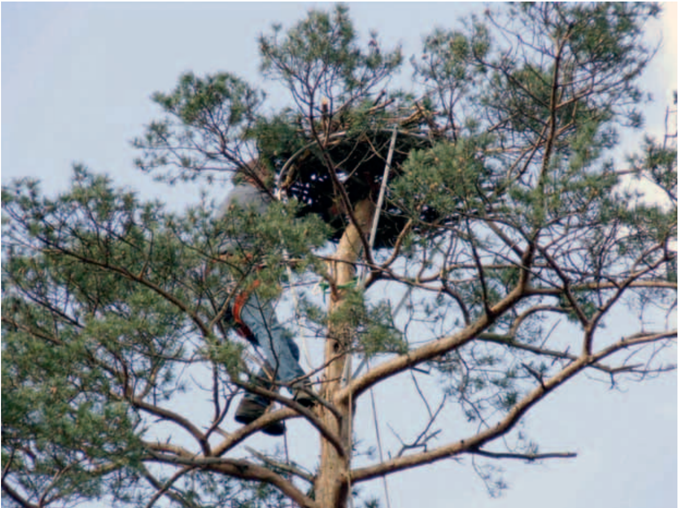
Abb.4: Bau eines Fischadler-Kunsthörstes auf einer freistehenden Kiefer. Foto: Bernd Struwe-Juhl
