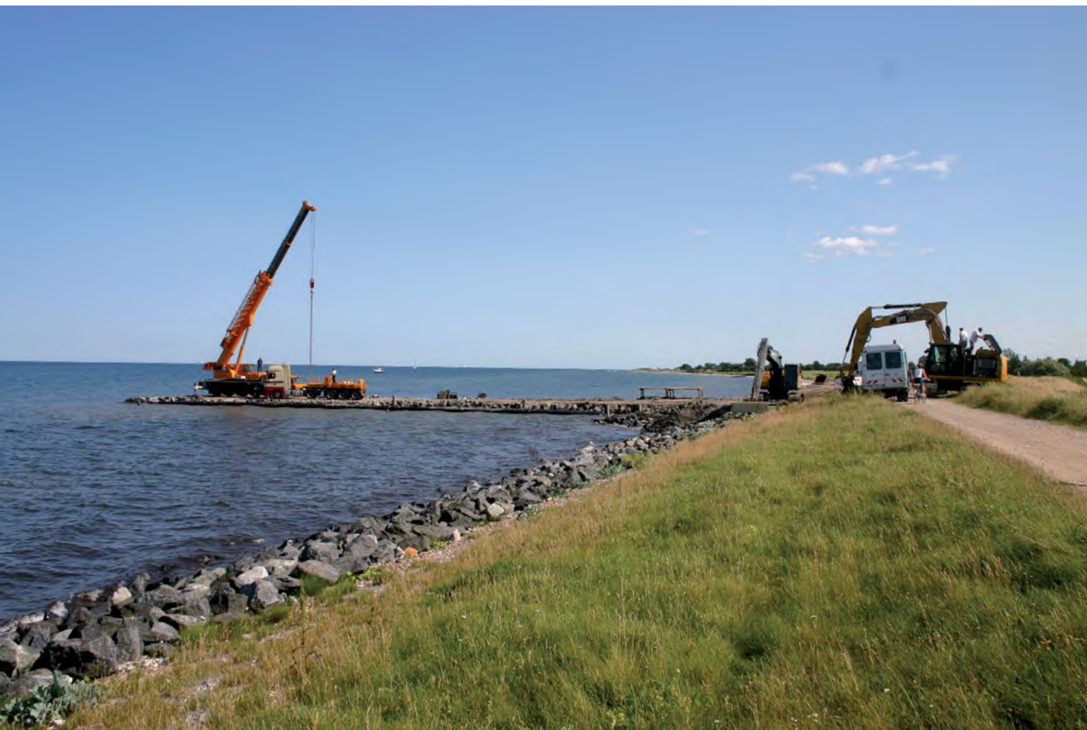
Abb.1: Bau des Einstromwerks Foto: Nils Kobarg
