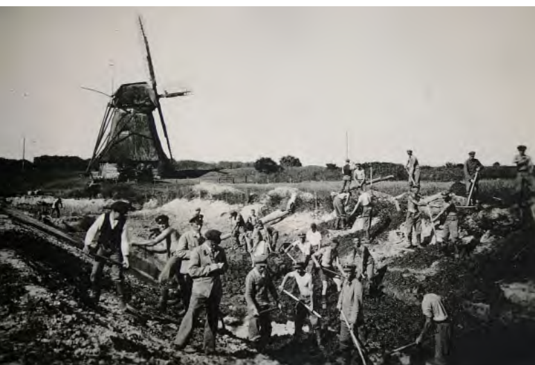
Grabenausbau von Hand in den dreißiger Jahren
